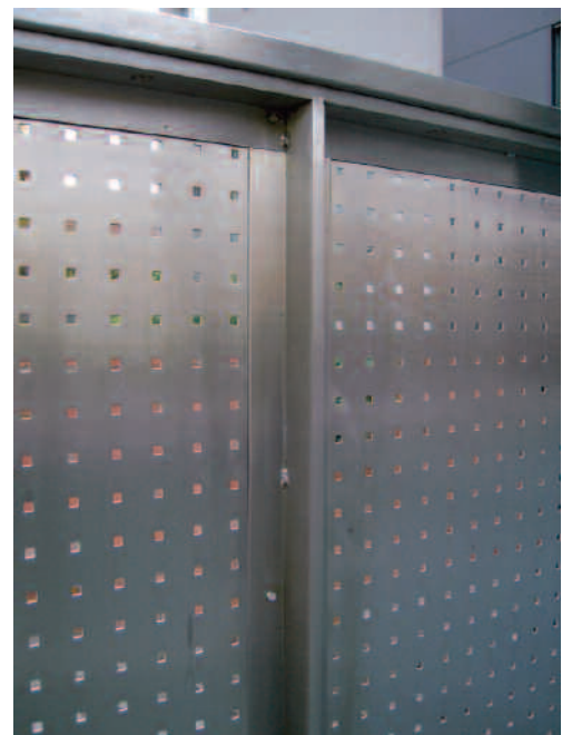
Schleifscheiben, die zuvor auf Kohlenstoffstahl eingesetzt worden sind, hinterlassen auf nichtrostendem Stahl örtliche Korrosionserscheinungen (links). Derartige Fremdeisenverunreinigungen lassen sich durch Beizen entfernen (rechts) [12].
